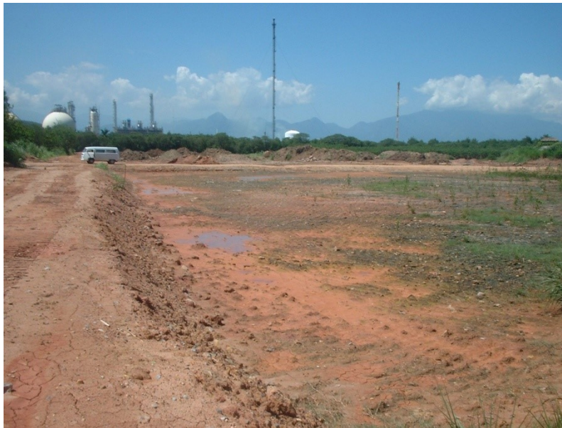
Bloco 4B em início de plantio, com vista à esquerda para a rua projetada e ao fundo o início dos trabalhos de rebaixamento do bloco 2A
