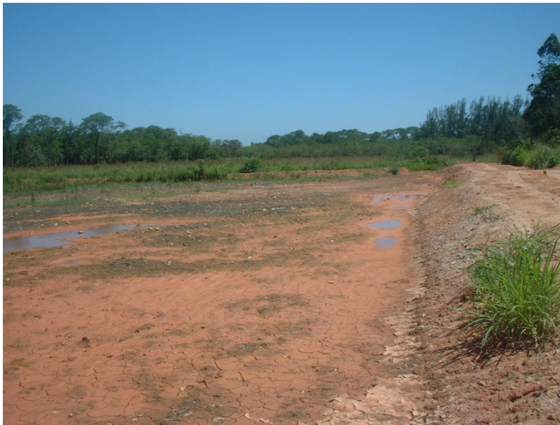
Área preparada para plantio no bloco 4B, com vista da rua projetada à direita
