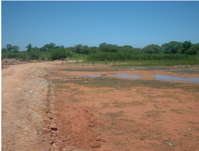
Área preparada para plantio no bloco 4B, com vista da rua do campo de futebol à esquerda
