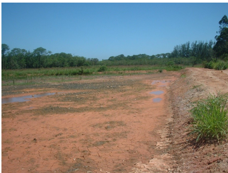
Área preparada para plantio no bloco 4B, com vista da rua projetada à direita
