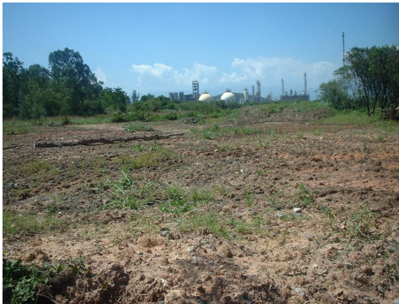
Área do bloco 4B antes do rebaixamento ao nível da maré de sizígia
