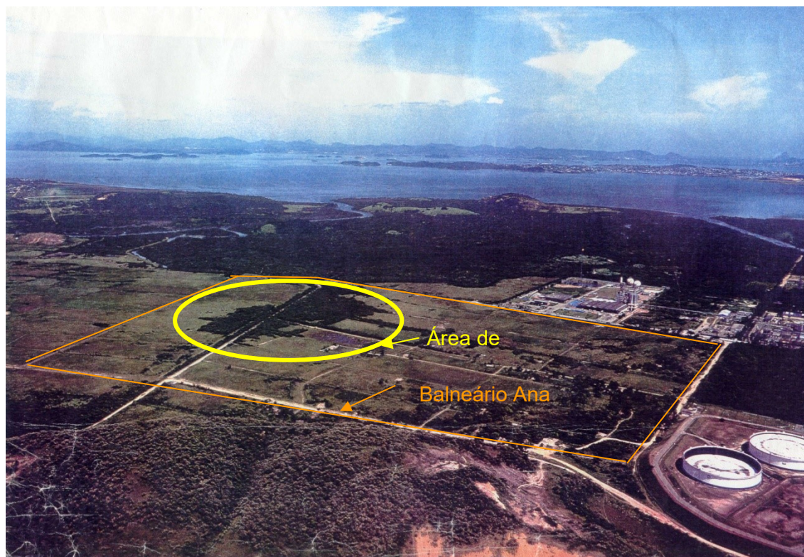
Foto 01. Vista aérea do Balneário Ana Clara, com destaque para a área de manguezal
