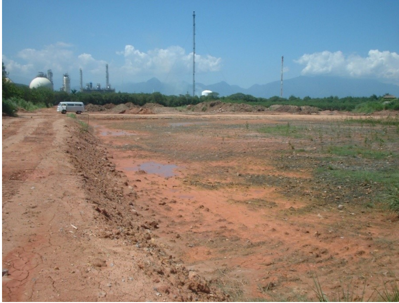
Bloco 4B em início de plantio, com vista à esquerda para a rua projetada e ao fundo o início dos trabalhos de rebaixamento do bloco 2A
